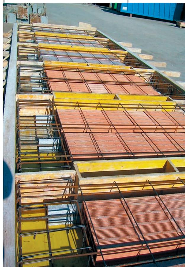
Fig. 13 - Fase di confezionamento dei prototipi.
